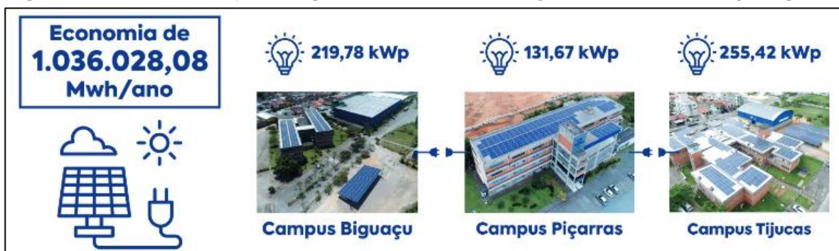
Figura 22 – Economia alcançada com painéis fotovoltaicos no Programa de Eficiência Energética por Campi
